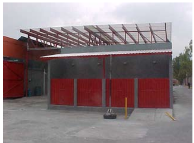
Centro de acopio Foto: Ing. Griselda Polanco Segovia
